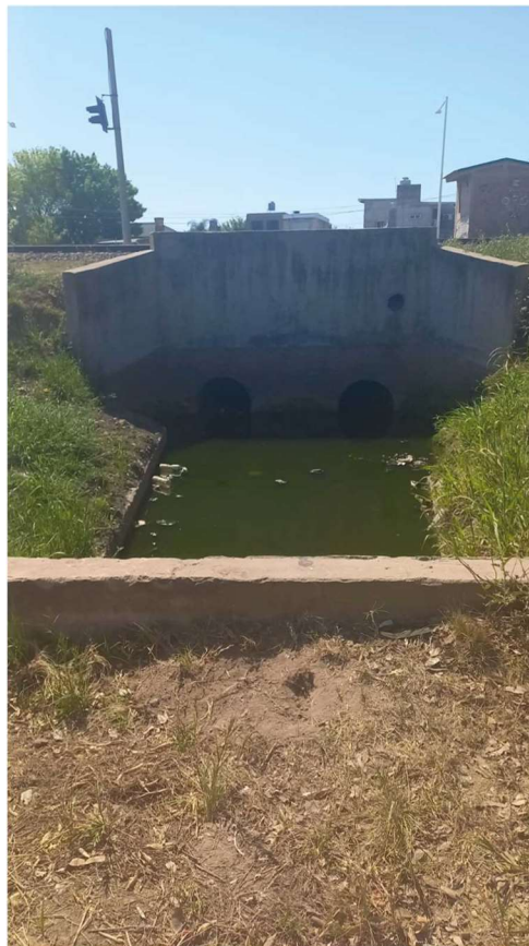
Foto 2 - PUNTO 2: Alcantarilla de Crisantemos y Belgrano, por arriba cruza el ferrocarril
