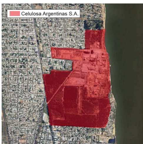
Figura 26 - Predio de Celulosa
