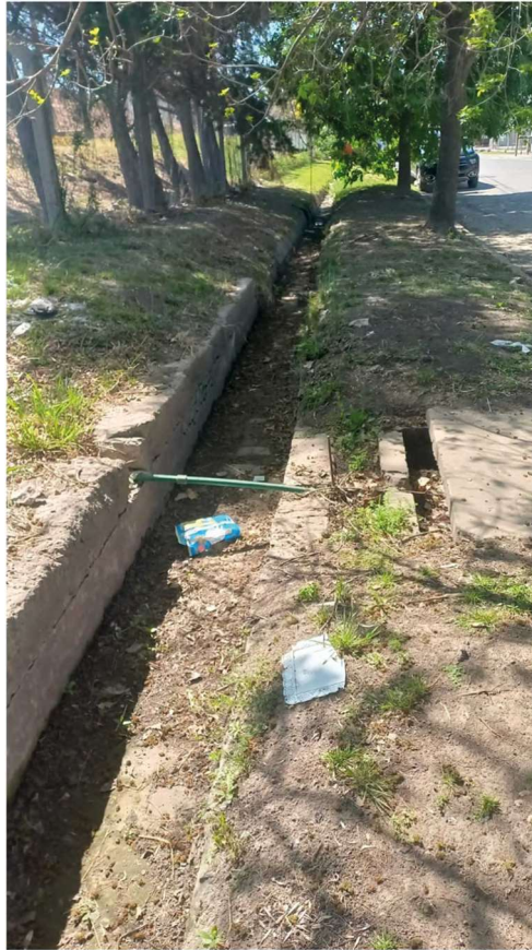
Foto 5 - PUNTO 5: Canal Pomillo desde la entrada de Celulosa Argentina.
