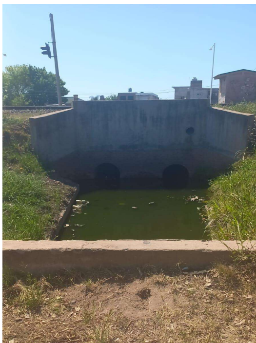
Foto 12 – Alcantarilla canal Crisantemos. Ubicación Figura 13 (punto 2)
