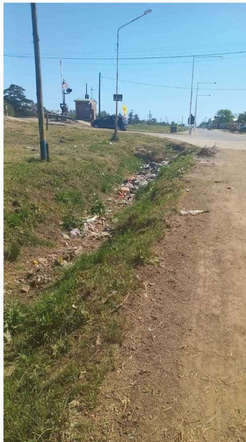
Foto 4 - PUNTO 4: Canal Belgrano paralelo al ferrocarril en el cruce con calle Crisantemos.
