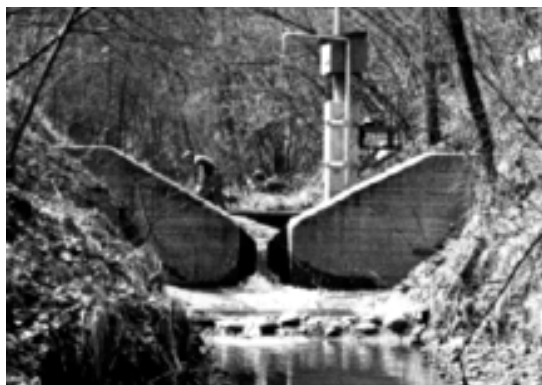
Figura 4.10 Reservorio de sedimentación en el Río della Gallina, Italia (Anselmo y Maraga, 1987).
