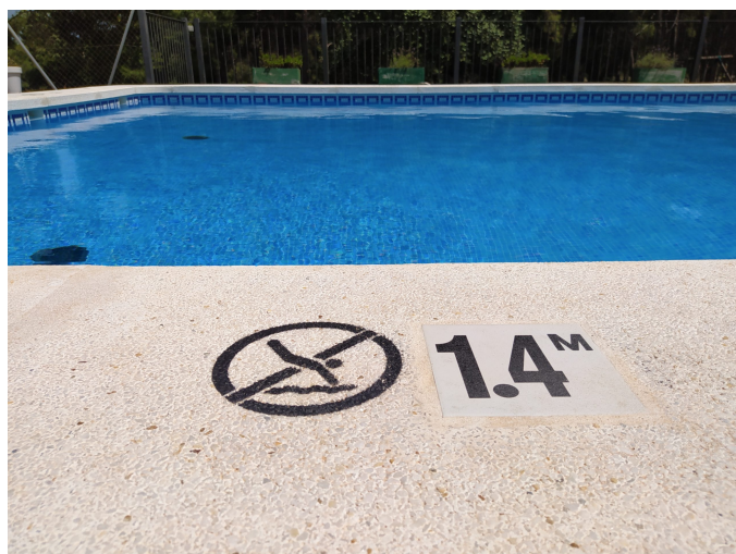
Señalética de profundidad de la piscina y una instrucción de prohibición.
