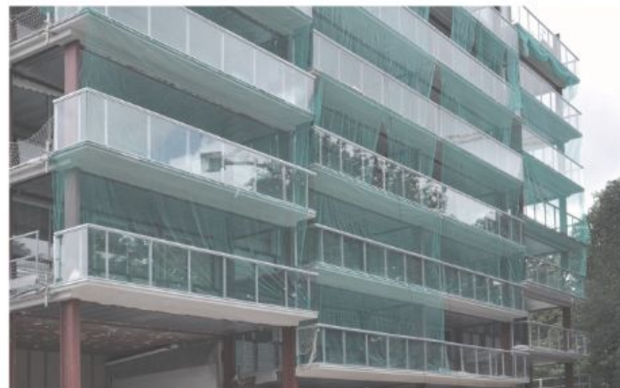
Transformación de un edificio habitacional de París del 60" Locaton & Vassal
