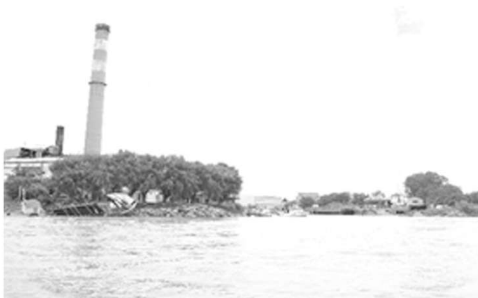
• Instalación del Frigorífico Swift. • Fundación Pueblo Nuevo
