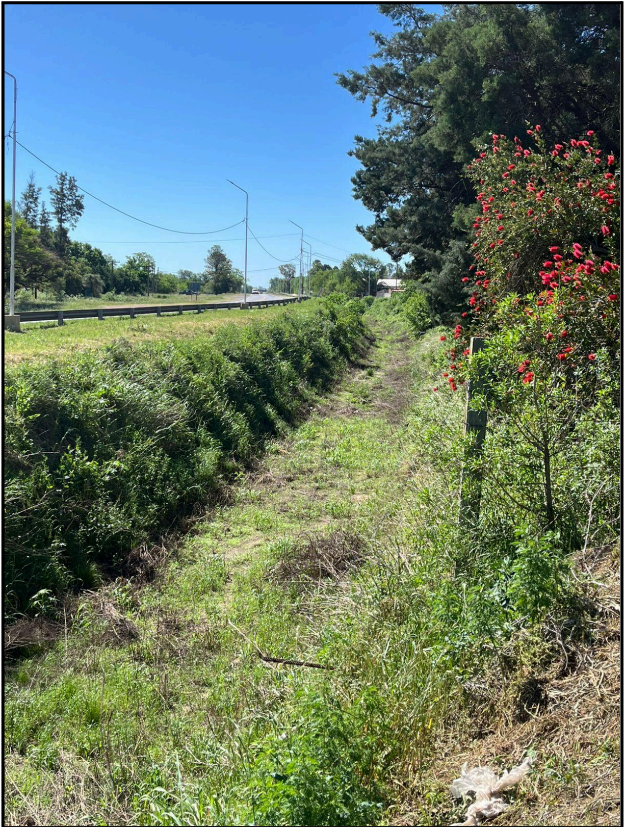
Imagen 15.1.5. Canal 12 de Octubre. Fuente: Elaboración propia.
