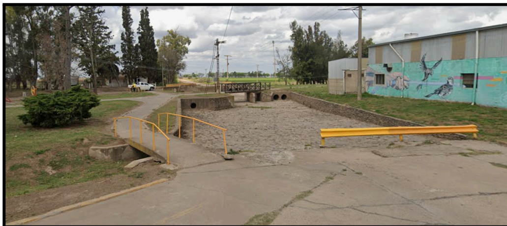
Imagen 3.6.5. Alcantarilla bajo FFCC en intersección calle Río Negro. Fuente: Google Maps
