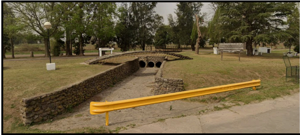
Imagen 3.6.7. Alcantarilla bajo FFCC en intersección calle Emilia Bertolé. Fuente: Google Maps.
