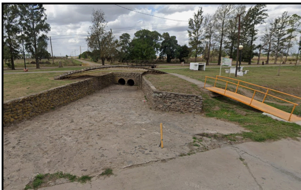
Imagen 3.6.6. Alcantarilla bajo FFCC en intersección calle Rosario. Fuente: Google Maps
