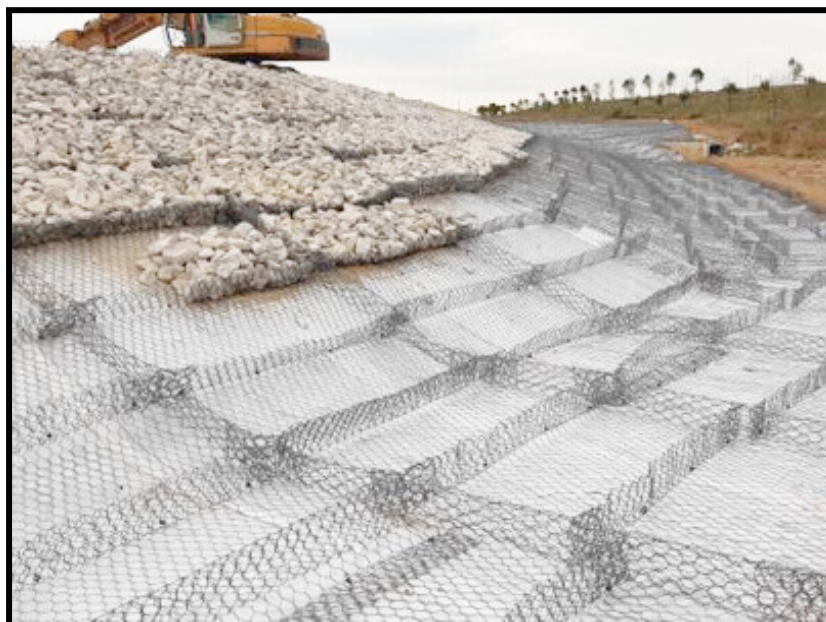
Imagen 9.2.1. Imagen ilustrativa de colchoneta de gaviones.
