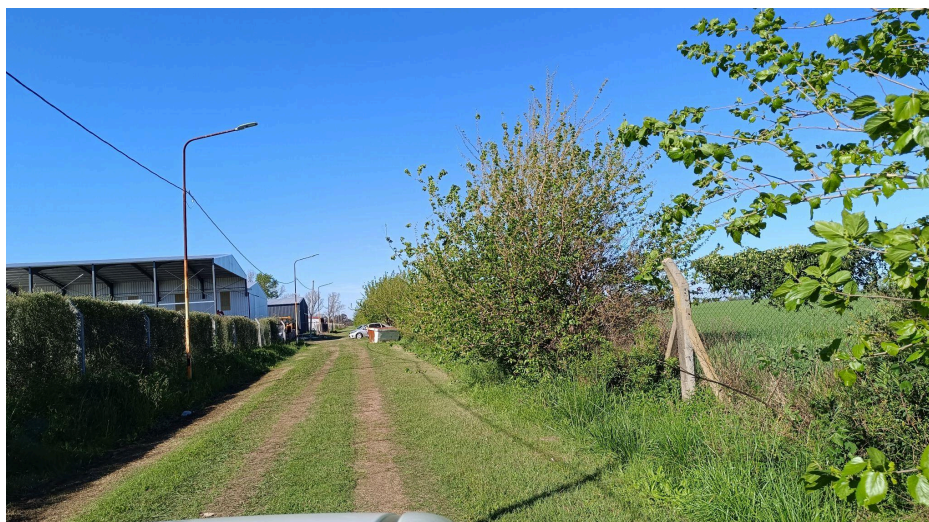
Imagen 35. Calzada de suelo natural sin estabilización. Fuente: elaboración propia.
