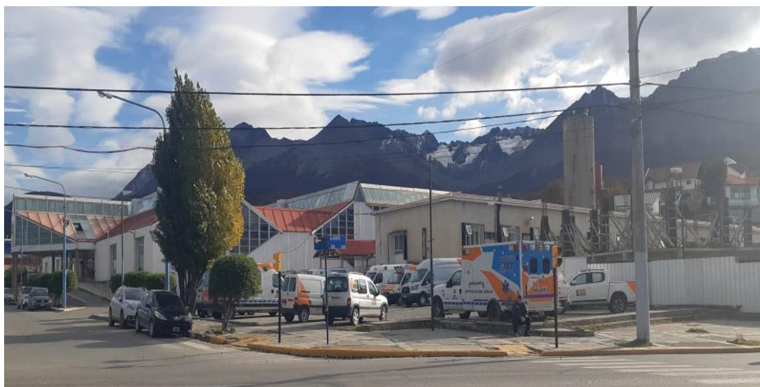
Esq. Maipú y 12 de Octubre, internación maternidad y obra de ampliación inconclusa.
