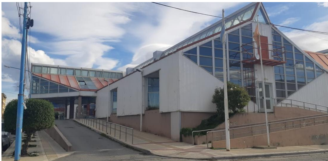
Rampa de acceso a Maternidad (hacia la derecha) e Ingreso Principal.
