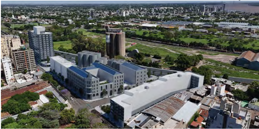
Imagen aérea de la intervención
