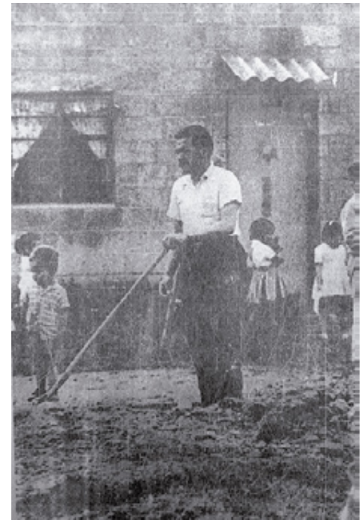
Figura 6. Continuidad de los trabajos de autoconstrucción para el mejoramiento de los espacios públicos en Ciudad Kennedy, después de habitado. Fuente: ICT, 1965.
