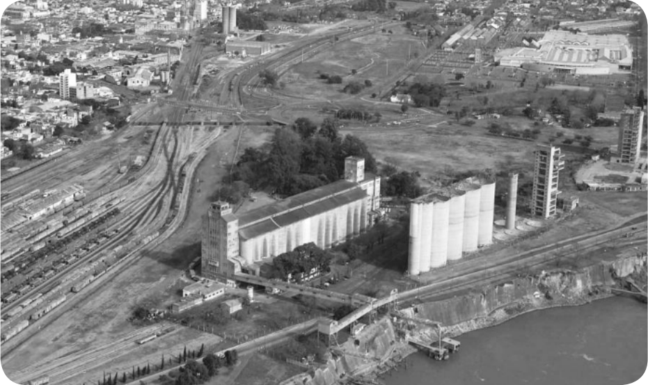
ANTIGUO PREDIO DE SERVICIOS PORTUARIOS.
