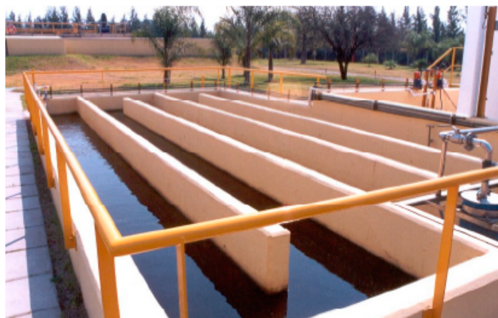
Figura 40. Cámara de desinfección.
