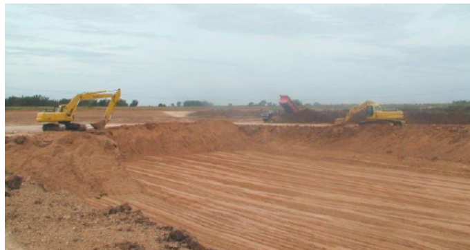
Figura 33. Construcción de celdas. Fuente: Google imágenes
