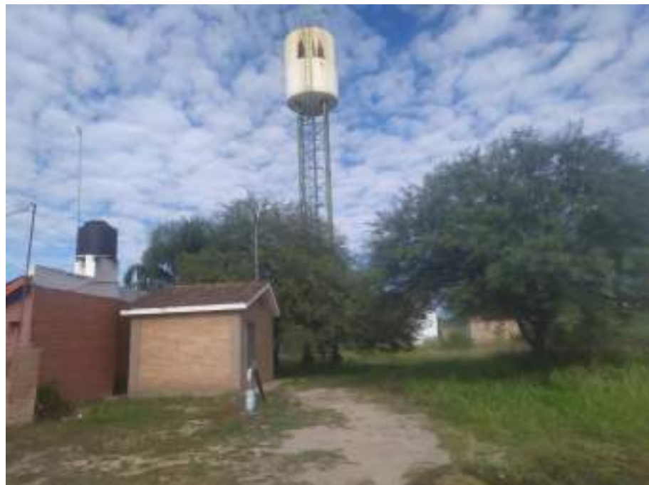
Foto 2 – Pozo de Bombeo N° 4.
