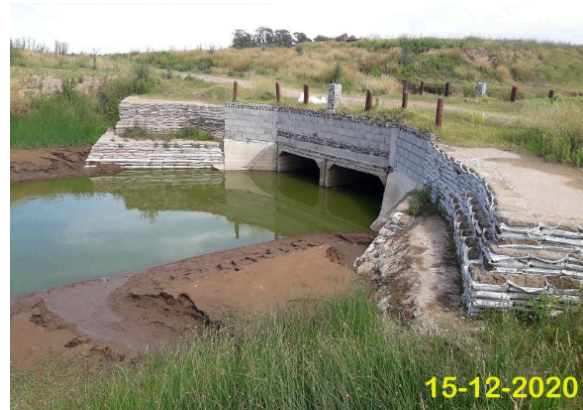
Imagen n°48: Vista desde aguas arriba [12].
