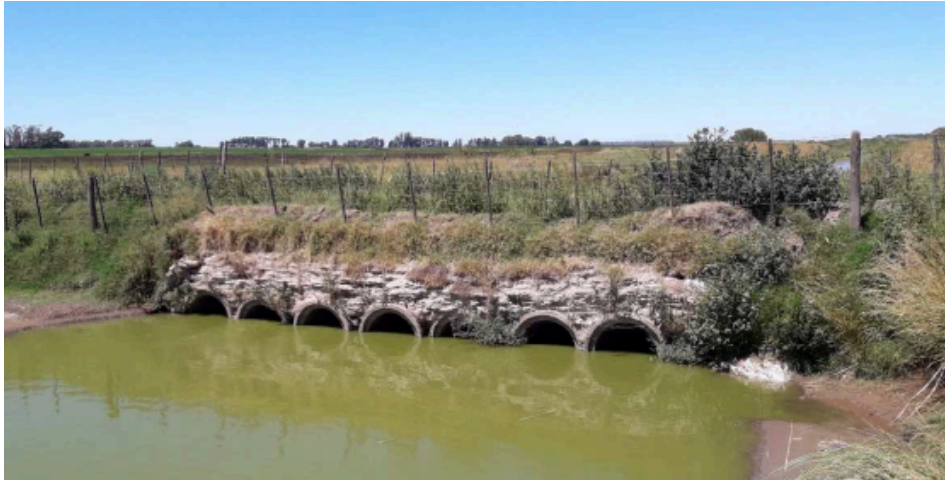
Imagen n°78: Vista desde aguas abajo A14 c [12].
