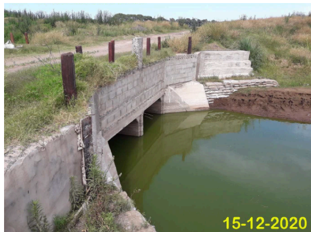
Imagen n°49: Vista desde aguas abajo [12].
