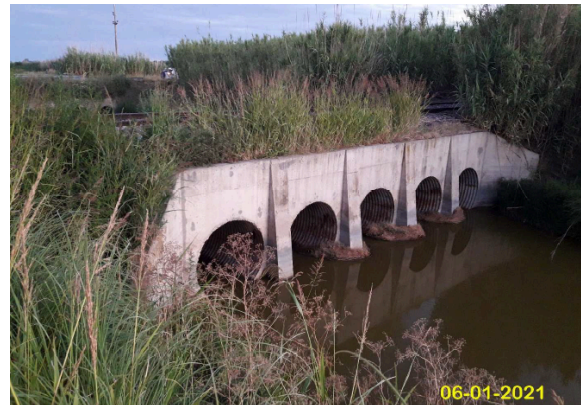
Imagen n°70: Vista desde aguas arriba A16 [12].
