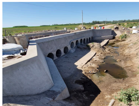
Imagen n°58: Estado actual de la alcantarilla (relevamiento propio) [12].
