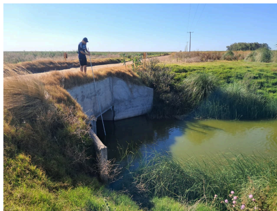
Imagen n°54: Vista desde aguas abajo (relevamiento propio).
