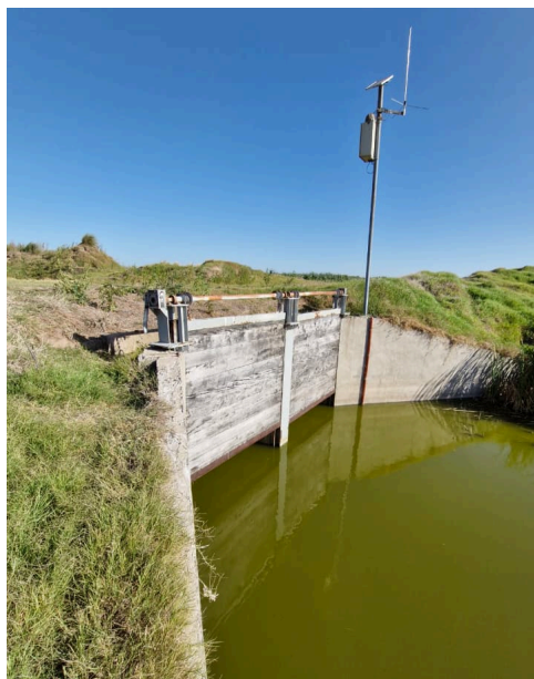
Imagen n°46: Vista desde aguas arriba (relevamiento propio).
