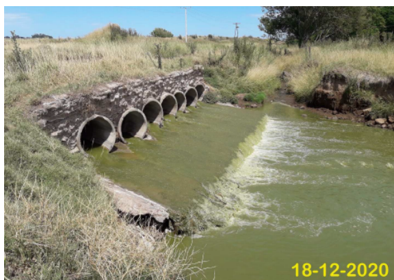
Imagen n°84: Vista desde aguas abajo A14 [12].
