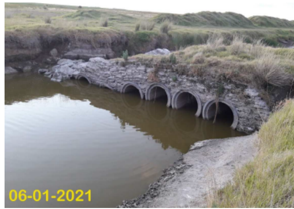
Imagen n°62: Vista desde aguas abajo [12].
