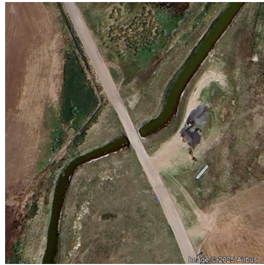
Imagen n°51 Estado actual alcantarilla G1 (01/11/2023).
