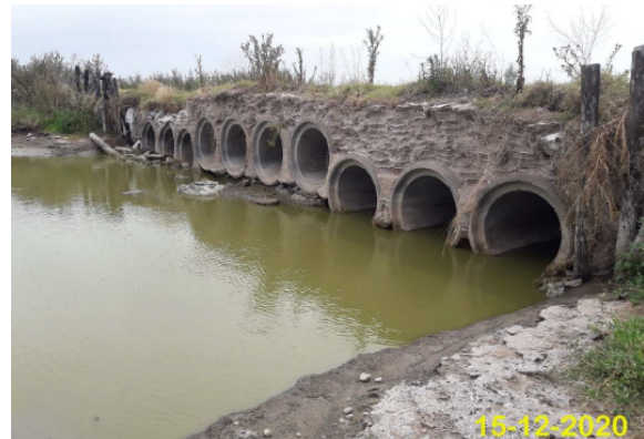
Imagen n°56: Vista desde aguas arriba (estado previo) [12].
