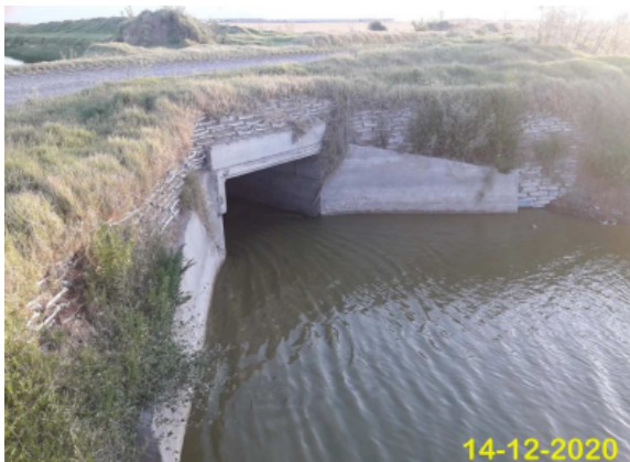
Imagen n°65: Vista desde aguas arriba [12].
