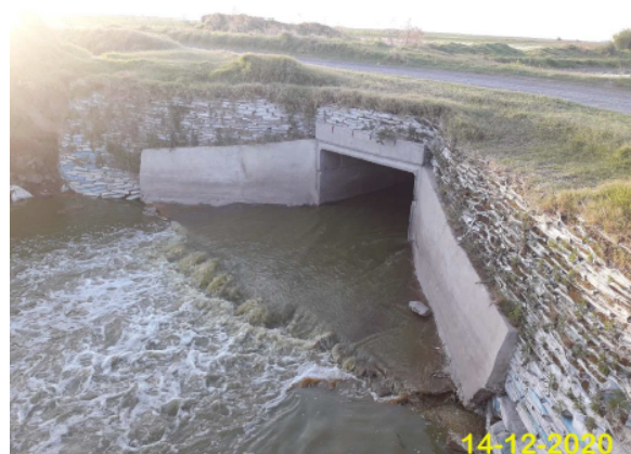
Imagen n°66: Vista desde aguas abajo [12].
