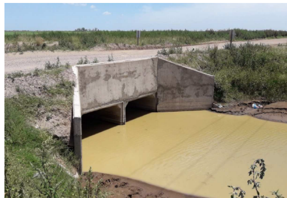
Imagen n°53: Vista desde aguas abajo [12].
