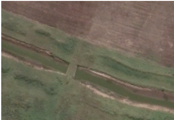
Imagen n°59: Estado anterior de alcantarilla 17a' (01/12/2014).
