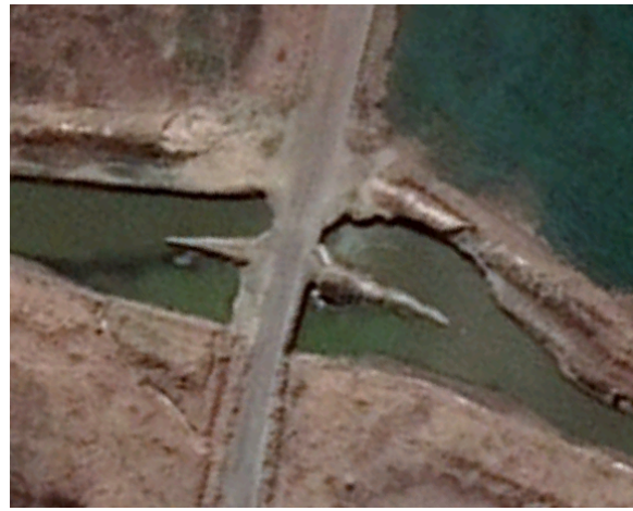
Imagen n°64: Estado alcantarilla 17-anulada (01/09/2019).
