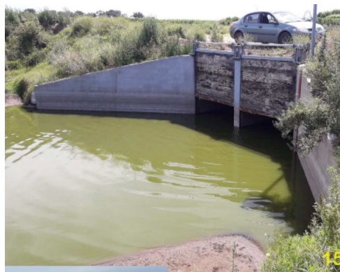
Imagen n°42: Estado actual alcantarilla G3 (01/11/2023).
