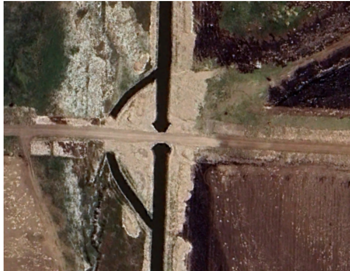
Imagen n°41: Estado actual alcantarilla G4 (01/11/2023).
