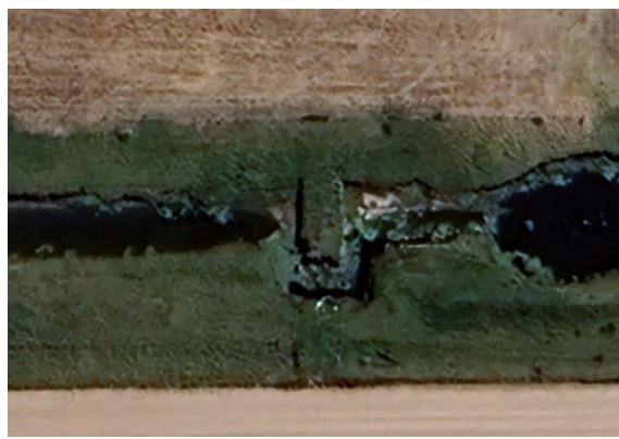
Imagen n°87: Estado actual de la Alcantarilla A13 (01/11/2023).
