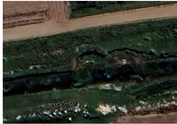
Imagen n°80: Estado actual de la Alcantarilla A14 a (01/11/2023).
