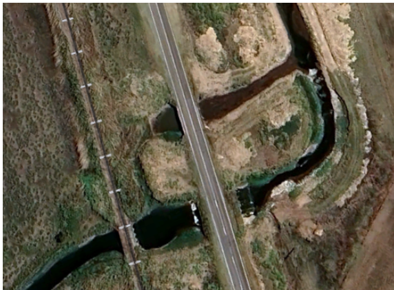
Imagen n°69: Estado actual de las Alcantarillas 15 y 16 (01/11/2022).
