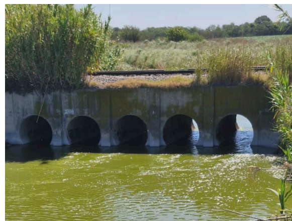
Imagen n°72: Estado actual de la alcantarilla A16 (relevamiento propio).
