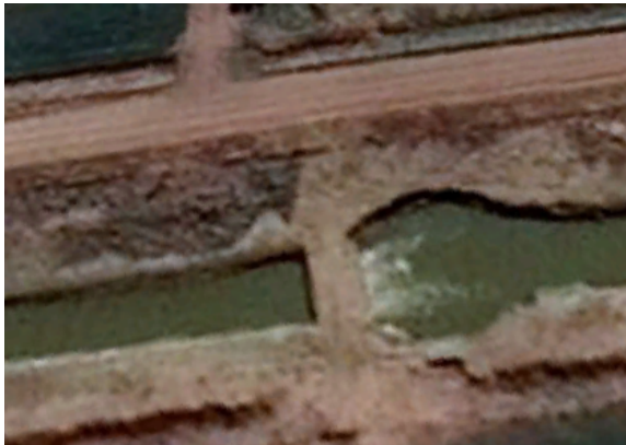
Imagen n°79: Estado anterior de la Alcantarilla A14 a (01/09/2019).
