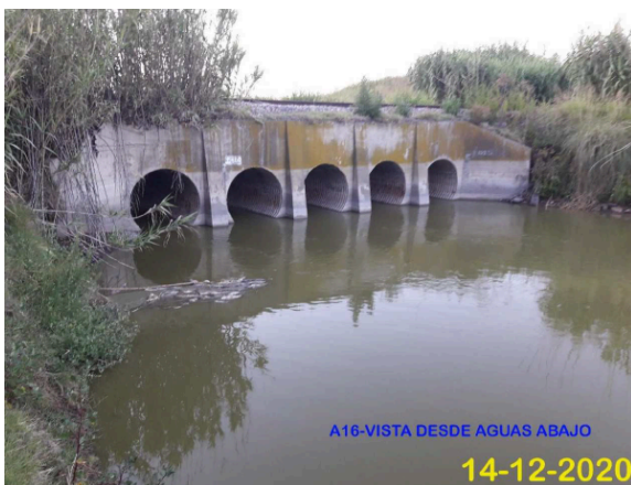
Imagen n°71: Vista desde aguas abajo A16 [12].
