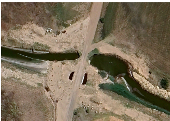
Imagen n°67: Estado actual Obra de Control (01/12/2022).
