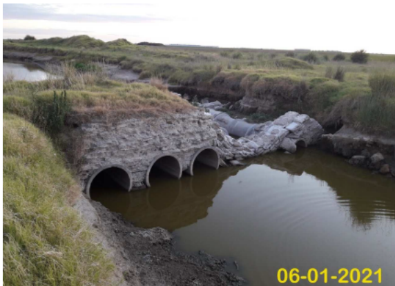
Imagen n°61: Vista desde aguas arriba [12].
