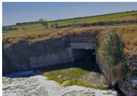
Imagen n°68: Estado actual de la alcantarilla (relevamiento propio).
