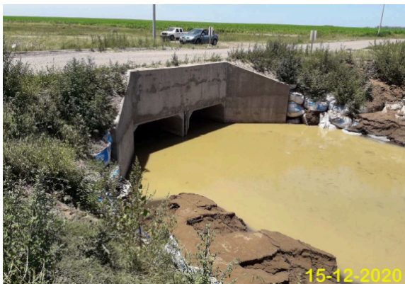
Imagen n°52: Vista desde aguas arriba [12].
