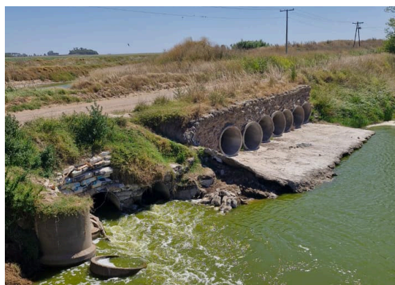
Imagen n°85: Estado actual de la alcantarilla A14 (relevamiento propio).
