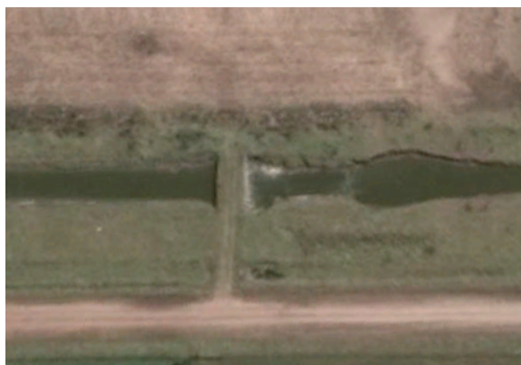
Imagen n°86: Estado anterior de la Alcantarilla A13(01/12/2014).
