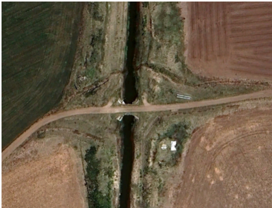
Imagen n°47: Estado actual alcantarilla G2 (01/11/2023).
