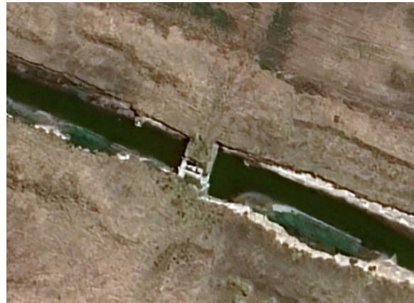
Imagen n°60: Estado actual alcantarilla 17a - En reparación (01/11/2022).
