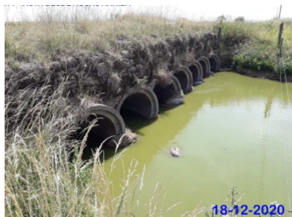
Imagen n°83: Vista desde aguas arriba A14 [12].
