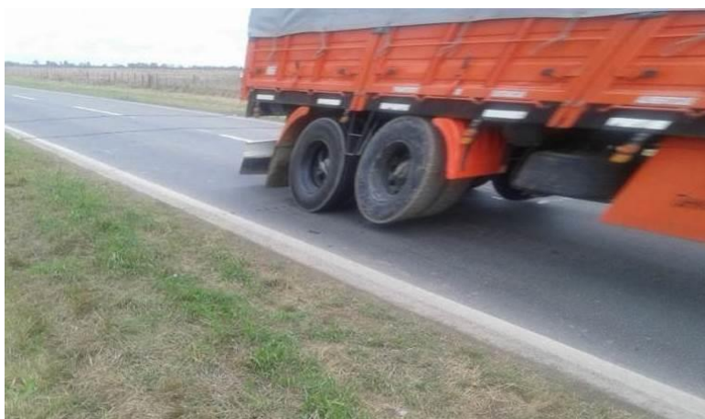
Figura 7.22. Foto relevamiento visual RN N° 11- Km 520,00
