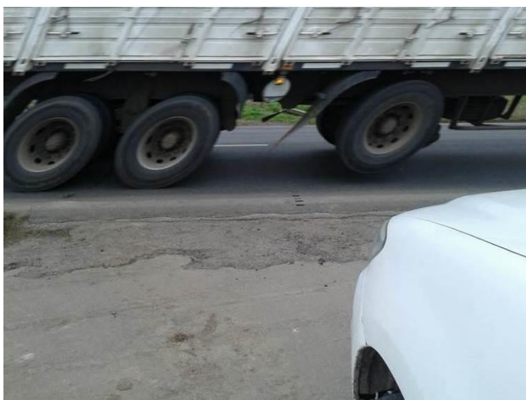
Figura 7.21. Foto relevamiento visual RN N° 11- Km 549,00
