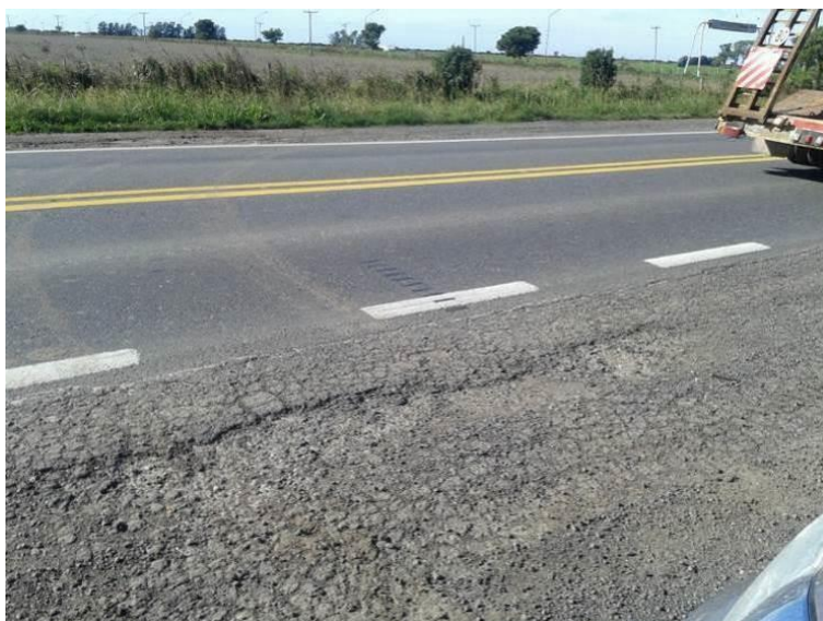
Figura 7.19. Foto relevamiento visual RN N° 34- Km 235,00
