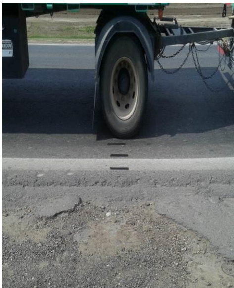
Figura 7.16. Foto relevamiento visual RN N° 34- Km 184,00
