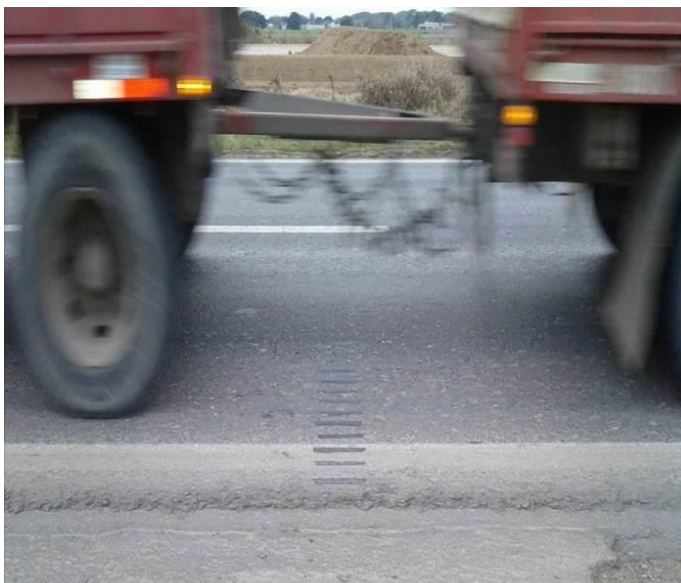
Figura 7.18. Foto relevamiento visual RN N° 34- Km 209,00
