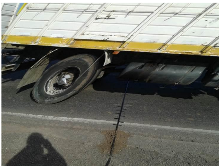
Figura 7.20. Foto relevamiento visual RN N° 34- Km 101,00
