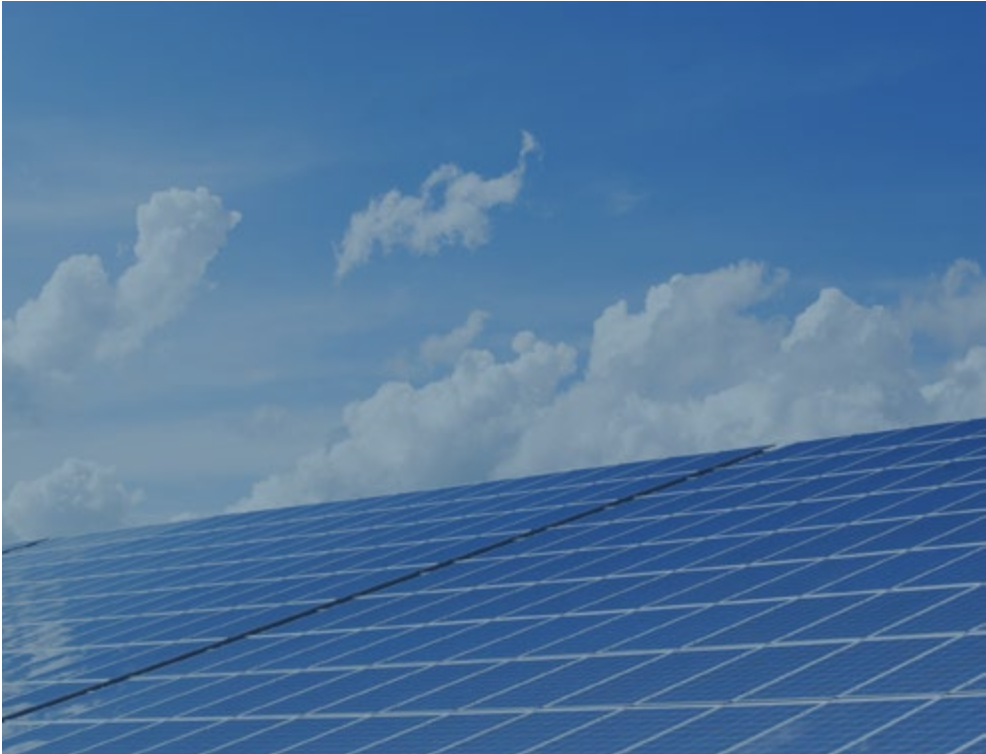
Fig.59 -Paneles Solares Fotovoltaicos.
