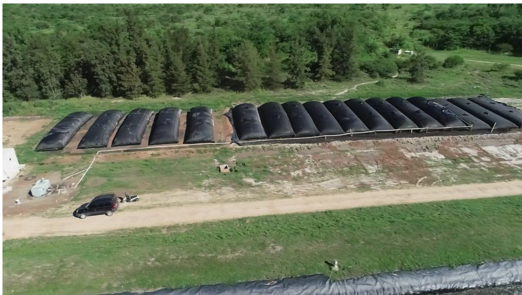
Figura 74: Tubos Geotextiles, PTAR DOGS 2019. Fuente: Elaboración Propia
