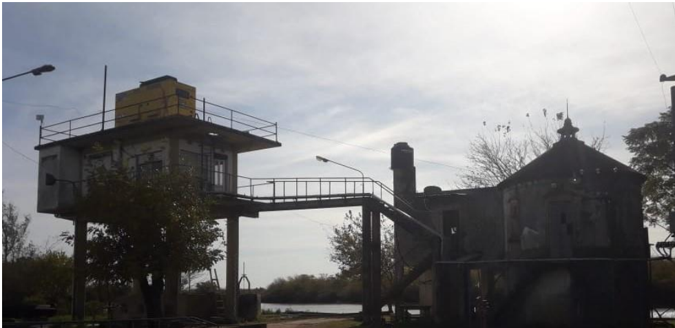
Figura 17: Foto Toma de agua DOSG. Fuente: Elaboración propia
