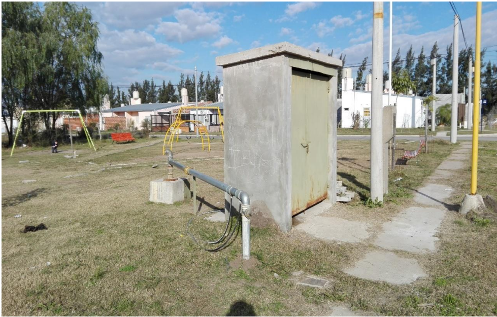
Figura 37: Fotografía de una casilla química correspondiente a una captación subterránea. Fuente: Elaboración propia
