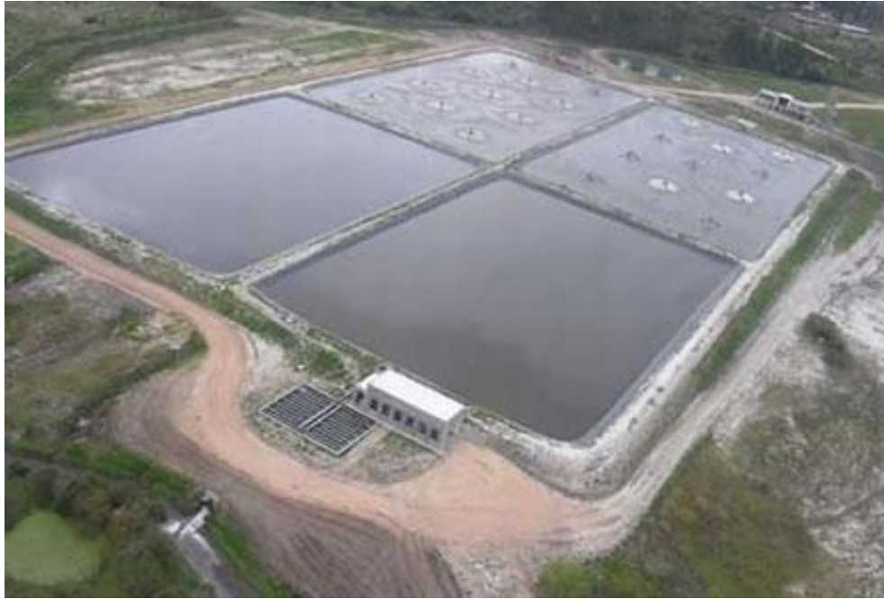
Figura 27: Planta de tratamiento de efluentes de la ciudad de Gualeguaychú. Enero 2007 Fuente: Foto de Archivo DOSG
