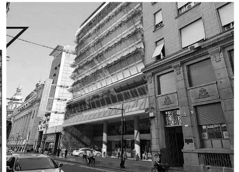
Edificio Armonía de BCR, sustentable
