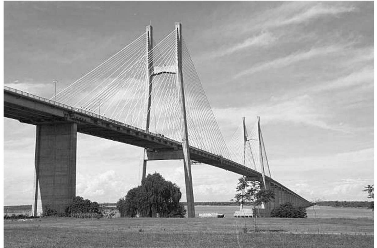
Puente Rosario - Victoria
