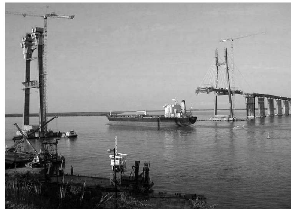
Construcción del puente
