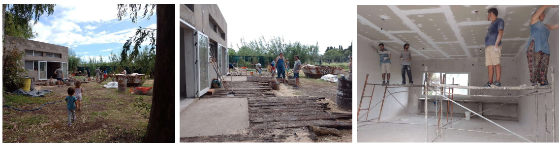
Construcción de aulas nuevas.
