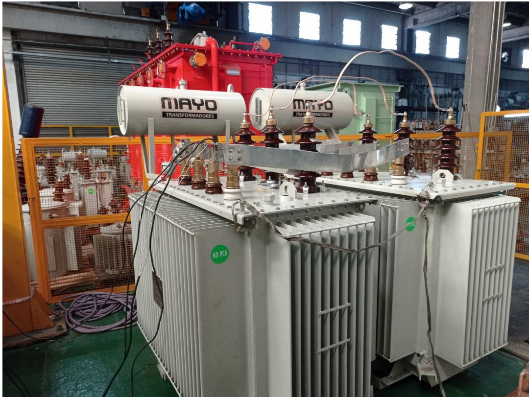
Figura 3-1: Transformadores de 1000 kVA en ensayo de calentamiento por método de oposición.
