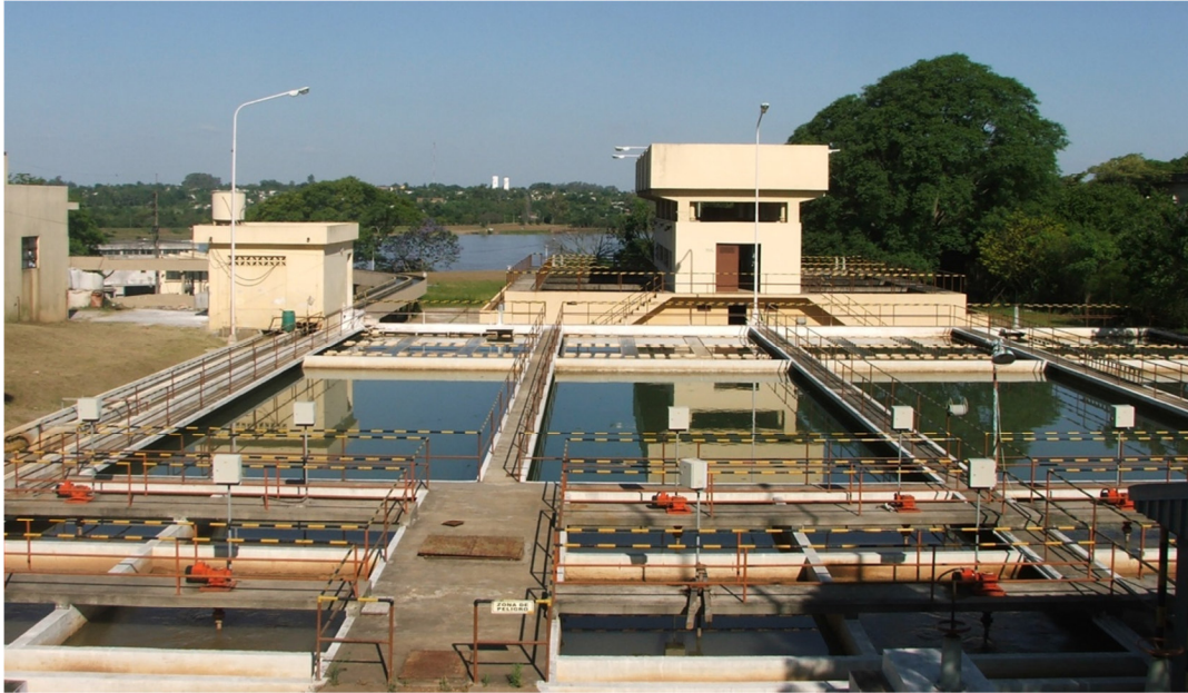
Figura 13: Módulo B de potabilización
