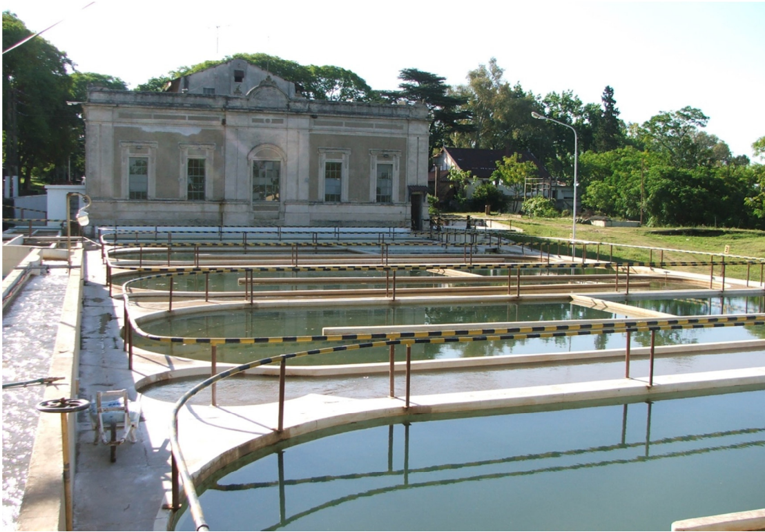
Figura 8: Módulo A de potabilización
