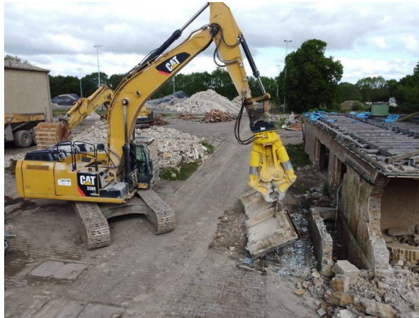
Figura 5: Mordaza de hormigón acoplada a excavadora.
