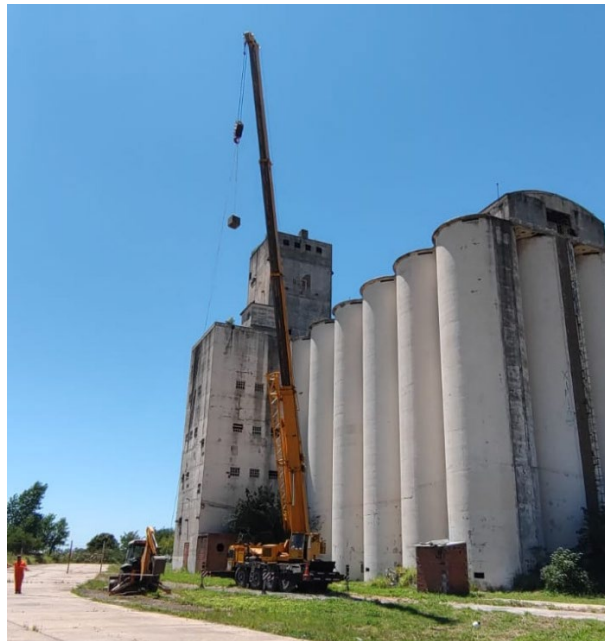
Figura 6: Equipo de izaje para ensayo de campo.
