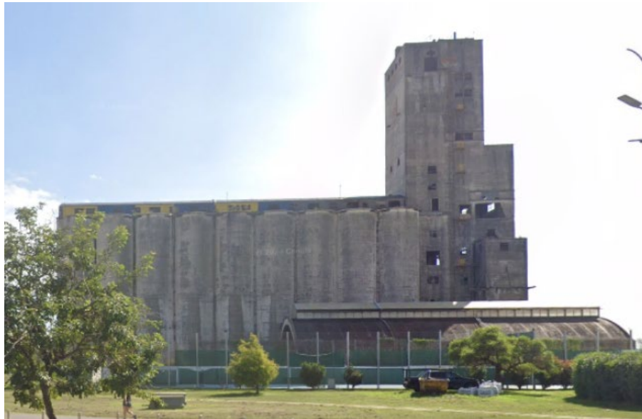
Figura 7: Estructura principal de silos a demoler.
