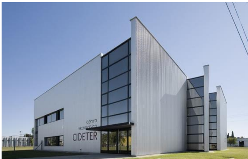
Edificio donde funciona CIDETER, unidad ejecutora del Clúster.
