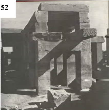
Figura 52 Sistema trilitico básico en la arquitectura del antiguo Egipto basado en el principio del apilamiento.
