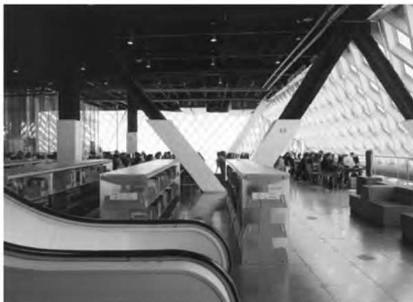
Figura 135 a 138. Fotografías del interior de la Biblioteca de Seattle donde se exhibe sin ningún prejuicio ni condicionante la estructura metálica portante y estabilizante del edificio. 135: Vista de la sala de lectura (nivel 10) limitada exteriormente por el gran entramado rigidizante que permite una gran iluminación natural. 136: Vista de la sala de estar ubicada en el tercer nivel y del espacio en gran altura que surge de este y le brinda al edificio una continuidad espacial hasta el nivel superior de las oficinas. 137: Vista parcial del entramado exterior que conforma la piel y la carcasa rigidizante. 138: Vista de la sala de mezclas ubicada en quinto piso donde se reconoce la gran cercha reticulada que sostiene por encima la espiral de libros y por debajo el nivel correspondiente a la asamblea.
