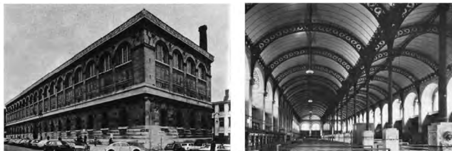
Figura 28. Henri Labrouste. Biblioteca de Saint Genevieve. París. 1844 – 1850. Una de las primeras obras en donde se empleó casi por completo la estructura metálica como soporte estructural el cual, sin embargo, no queda expresada como tal en la fachada. Esta situación resulta curiosa en un arquitecto que ha sido considerado como uno de los primeros racionalistas de la época.
