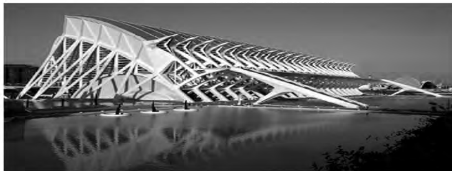
Figura 27. Santiago Calatrava. Museo de las Ciencias Príncipe Felipe, Valencia. España. 1994- 2000. Imagen exterior del conjunto. La expresión de la forma estructural es denotada y resaltada a través del esmero puesto en el diseño particular de los elementos que conforman el sistema, así como sus vinculaciones, que posiciona al detalle constructivo como vehículo de expresión de la forma arquitectónica.
