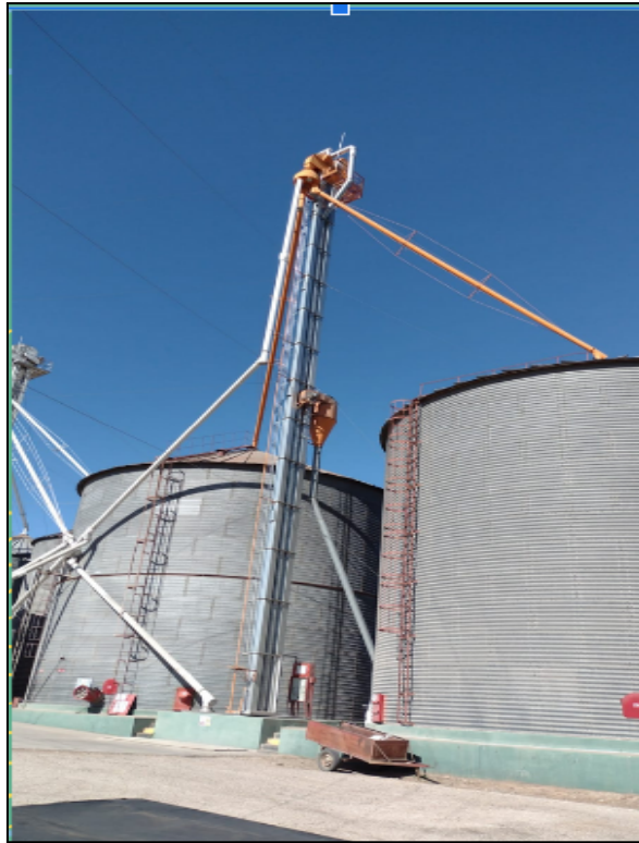
Figura 22: Instalación de nodo vista terrestre
