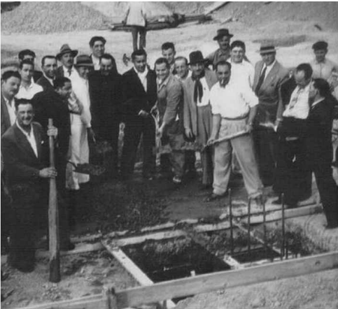
Obreros colocando la primer "palada" de cemento.
