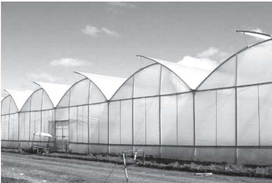
Sistemas bajo cubierta
