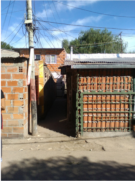
Pasillos entre viviendas, ausencia de veredas, límites confusos entre lo público y lo privado, irregularidades en la conexión eléctrica.
