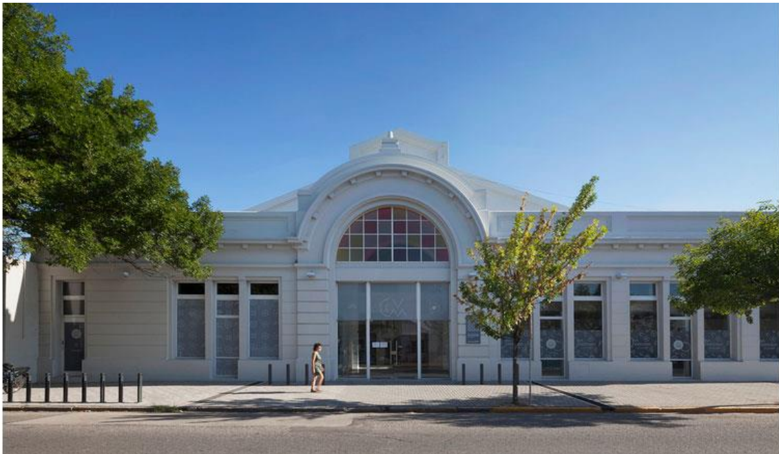
Fachada actual del CCVM, vista sobre calle Sarmiento. Fotografía de Federico Cairoli.
