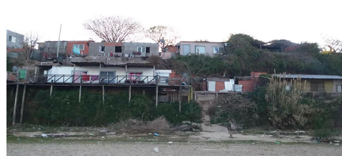
VIVIENDAS SOBRE PILOTES - REMANSO VALERIO
