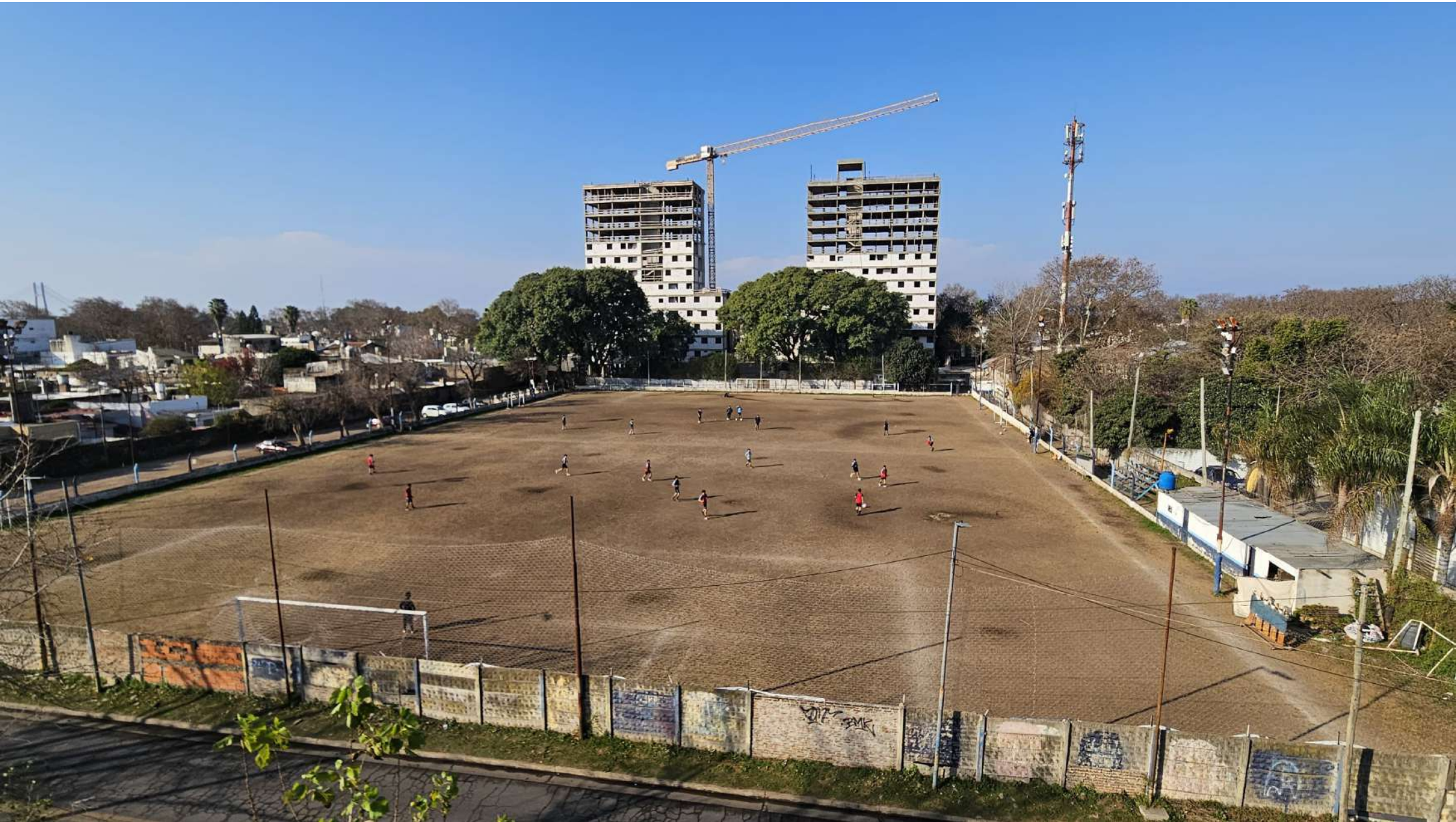
Estado actual Sector II
