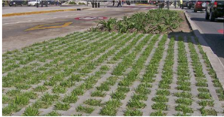
Figura 3.35 : Pavimento intertrabado verde - estacionamientos
