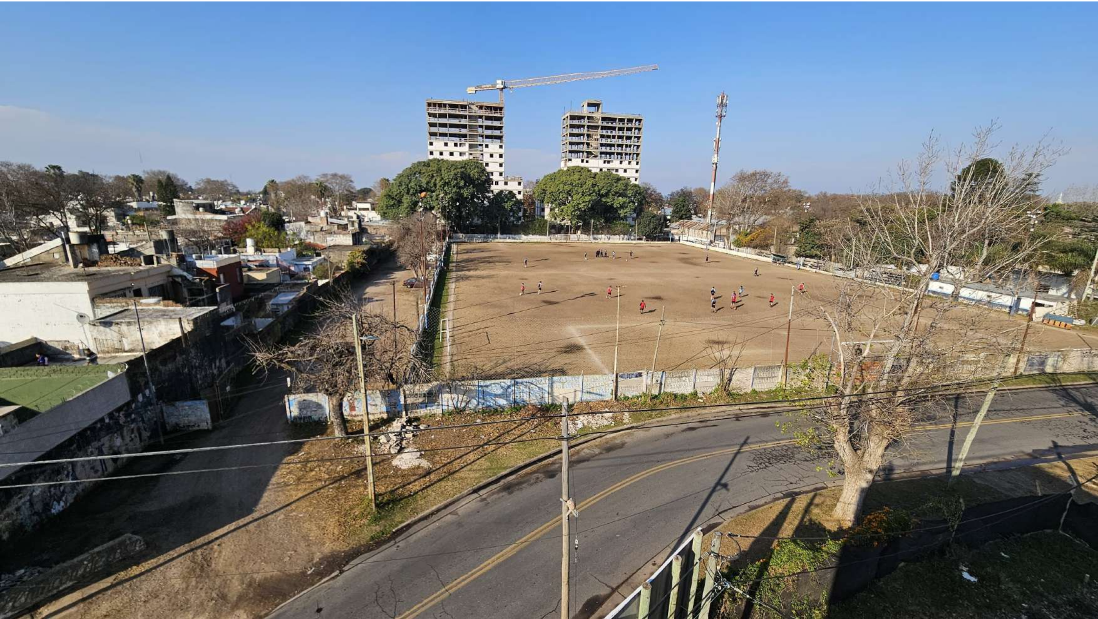
Estado actual Sector II
