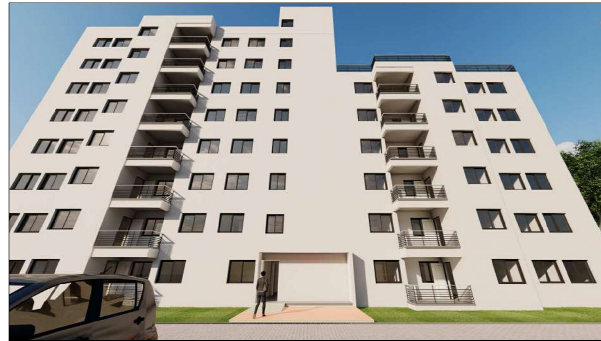
FACHADA SUR- BLOQUE M7A
