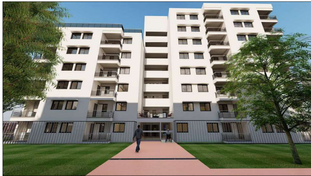
FACHADA NORTE- BLOQUE M7A
