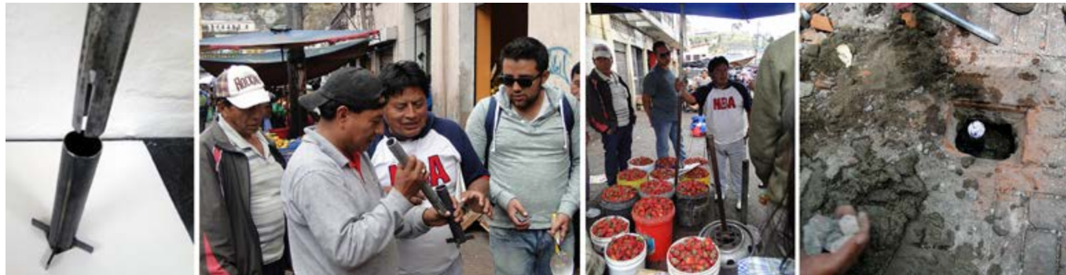
Figura 12. Prototipo de soporte de la sombrilla. Prueba y colocación en la vereda de la Asociación Ambrosio Lasso retirando solo 2 ladrillos. Fotografía: Daniel Viú.
