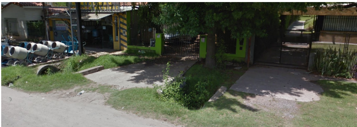
Figura N°07. Estado actual de las veredas. Ruta 9 y Candelaria.
