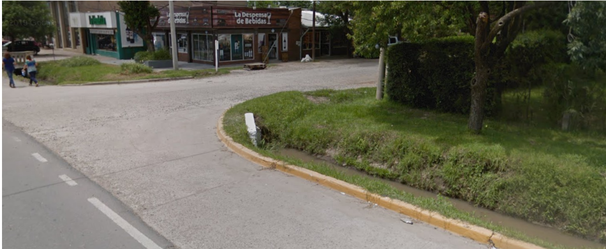
Figura N°08. Estado actual de las veredas. Ruta 9 y Moreno.
