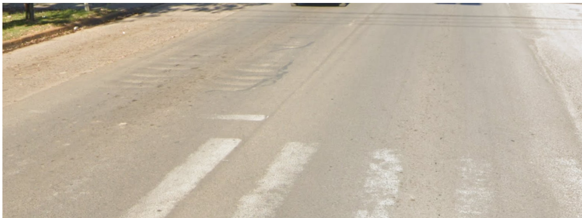
Figura N°17. Deformaciones en calzada. Ruta 9 y calle Yrigoyen.
