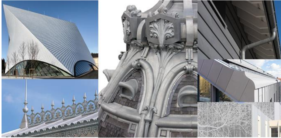
Figura 1.3: Aplicaciones de las aleaciones de zinc en la industria arquitectónica.
