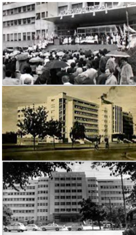
Imagen 10. Fotografía del Central en funcionamiento. Fuente: archivo AHTER
